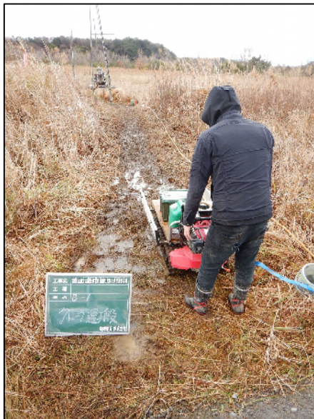
写 2-1-1 不整地運搬車搬入
