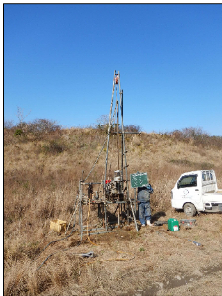
写 2-1-3 平坦地足場
