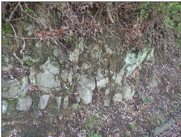
写 3-2-3 連結鉄塔箇所周辺の露岩状況
