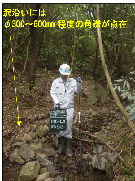
写 4-1-1 現地状況(防-C-14)
